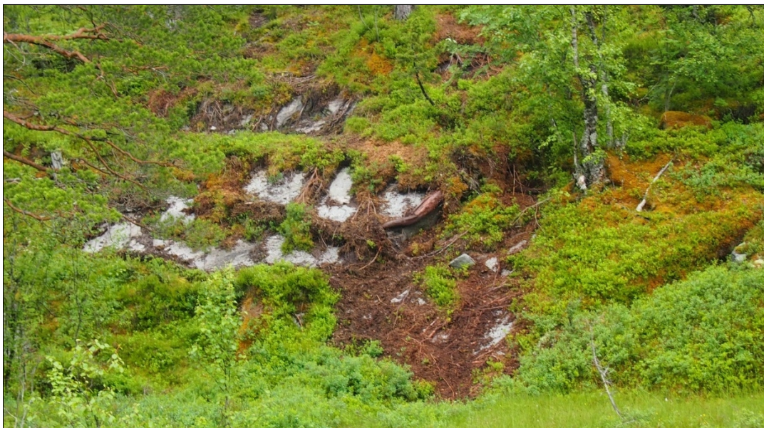
Bilde 7: Stien frå vestenden av Røssleivvatnet til Veten. Nedste parti er bratt og vanskeleg å gå. Stien er fuktig og ber preg av slitasje. På dei mest utsette plassane bør det lagast klopper og settast opp ein trapp.
