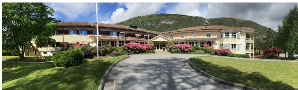
Bilde 2 - Omsorgssenteret før utbygging Foto: Siv Kvalsvik Haugen
