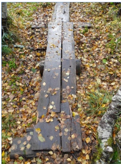
Bilde 4: Klopp over Bjørnalomyra. Koppene er prega av slitasje og råte. Denne stien er mykje brukt og kloppene må holdast ved like.
