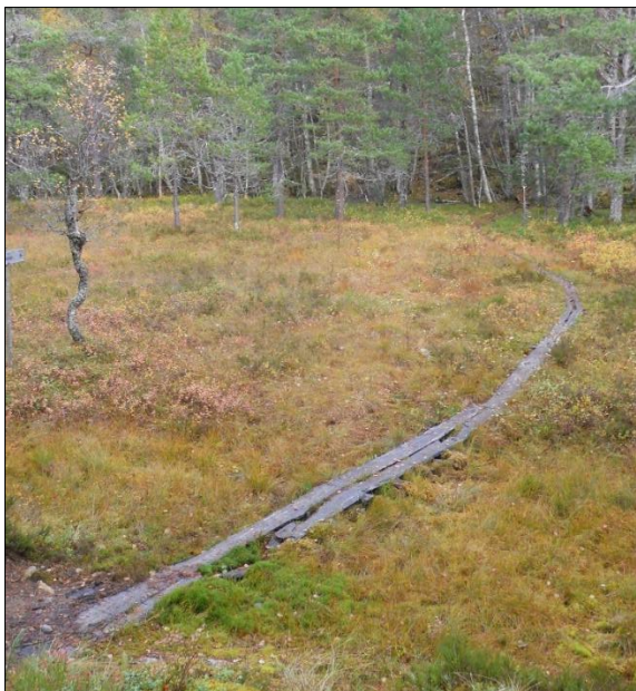
Bilde 4: Klopp over Bjørnalomyra. Koppene er prega av slitasje og råte. Denne stien er mykje brukt og kloppene må holdast ved like.
