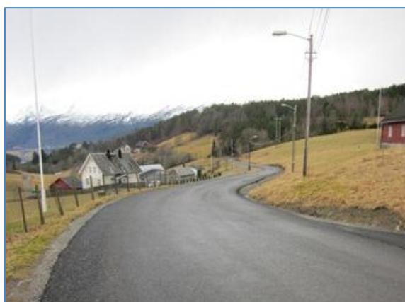
900 m grusveg på Føleide fekk fast dekke. Før asfalteringa på Føleide vart det utført grøfte-reinsk og lagt ut duk og eit pukklag på ei strekning med dårleg bæreevne. Foto: Ivar Skeistrand.
